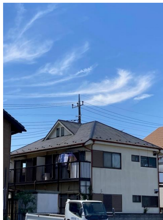
外観塗装改修
